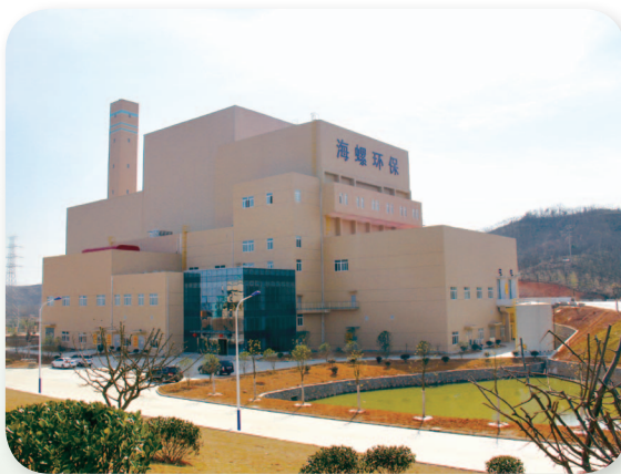
圖為在安徽金寨正式投產運行的公司首個爐排爐垃圾發電項目
